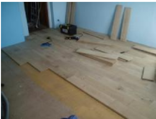
Verlegen von Fußbodenbelag auf Hohlraumboden
