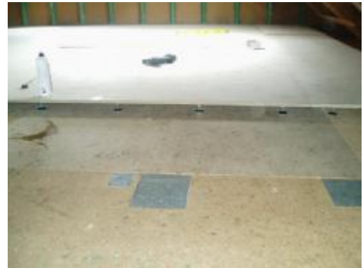
neuer Fußboden in Dachausbau
