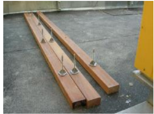
Fußdetail im Holzbalken
