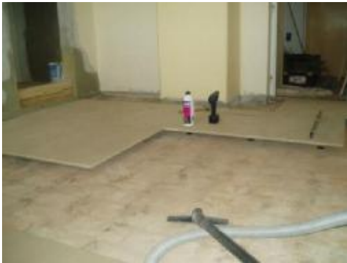
Höhenausgleich bei Umbau oder Sanierung
