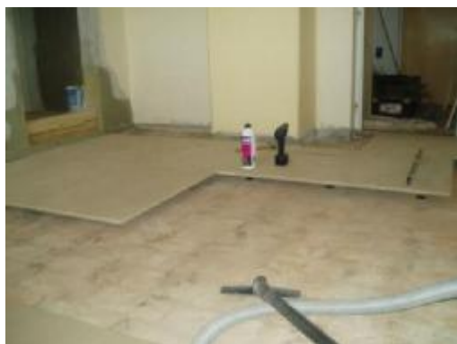
výškové vyrovnání podlahy při rekonstrukci
