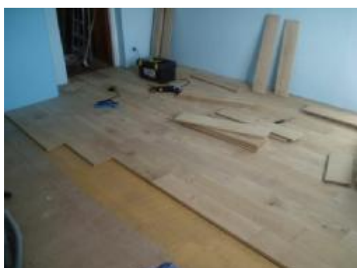
položení finální krytiny na podlahové desky na stojkách
